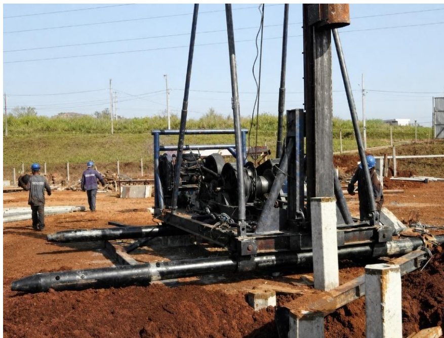
Figura 16 – Cravação de estaca a seco.
